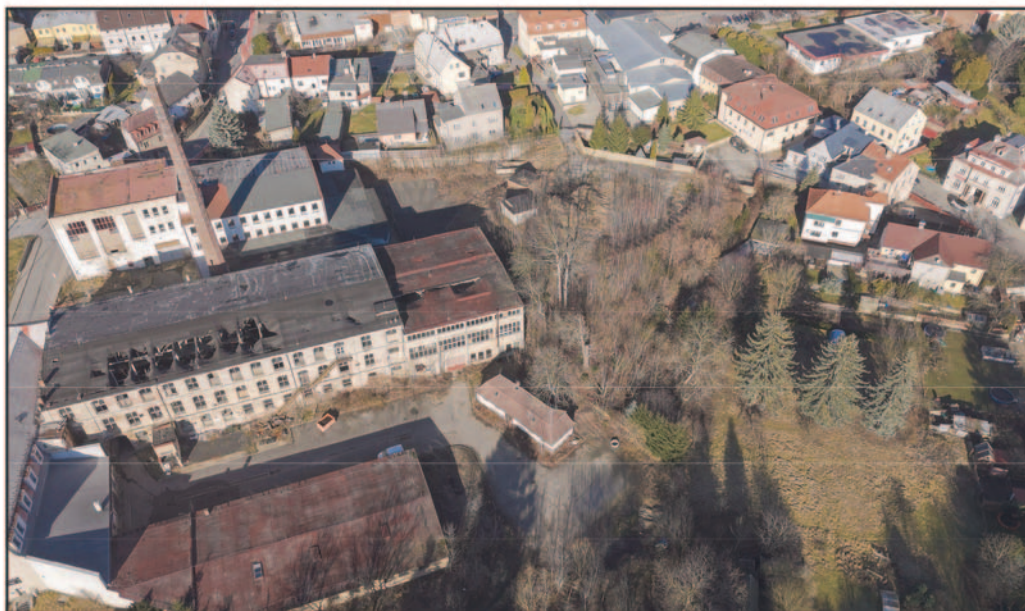
V letošním roce začne postupná proměna areálu Bekon. Objekty bývalé továrny budou kromě administrativní budovy a komínka zbourány a nahradí je Dům sportu, Archiv a depozit a Poliklinika. Proměnou projde i celé veřejné prostranství.
