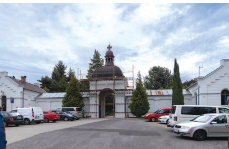
Oprava střechy vstupní brány na hřbitov
